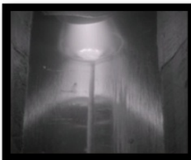
Pipe 용접 시공
